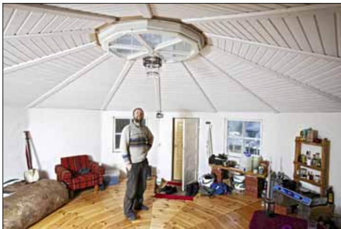
Ikkunatornista kajastaa päivänvaloa sisälle. Sampo Saloselle oli tärkeää rakentaa myös lattia viipelettäin pyöreäksi.
