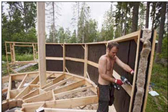
Maja koottiin ensi kertaa kesällä 2011. Elementtien välissä on pystyssä kumitivistet ja niiden keskellä eristekaistale.
