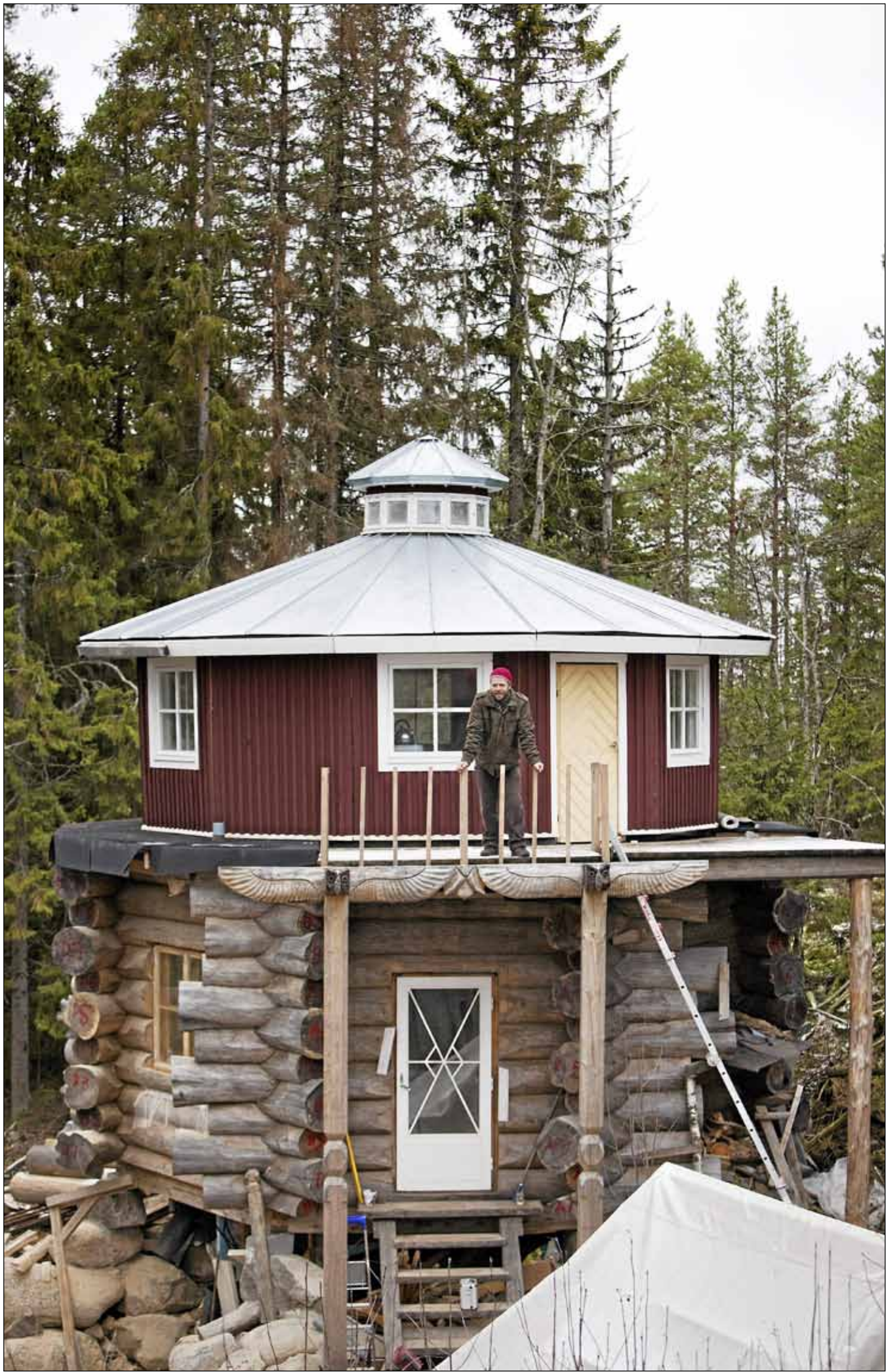
Sampo Salonen päätti sijoittaa pyöreän perinnerakennuksensa kuusikulmaisen hirsituvan yläkerraksi. Rakennustyöt alkavat olla loppusuoralla.
